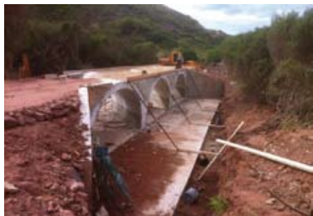
Construcció del pont a Els Alocs
